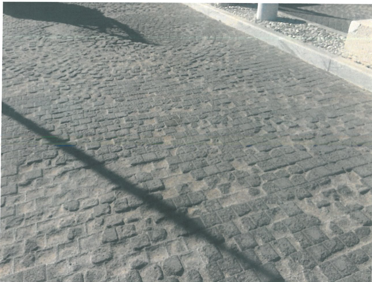
Φωτ.1: Υφιστάμενη κατάσταση υπό μελέτη περιοχής
