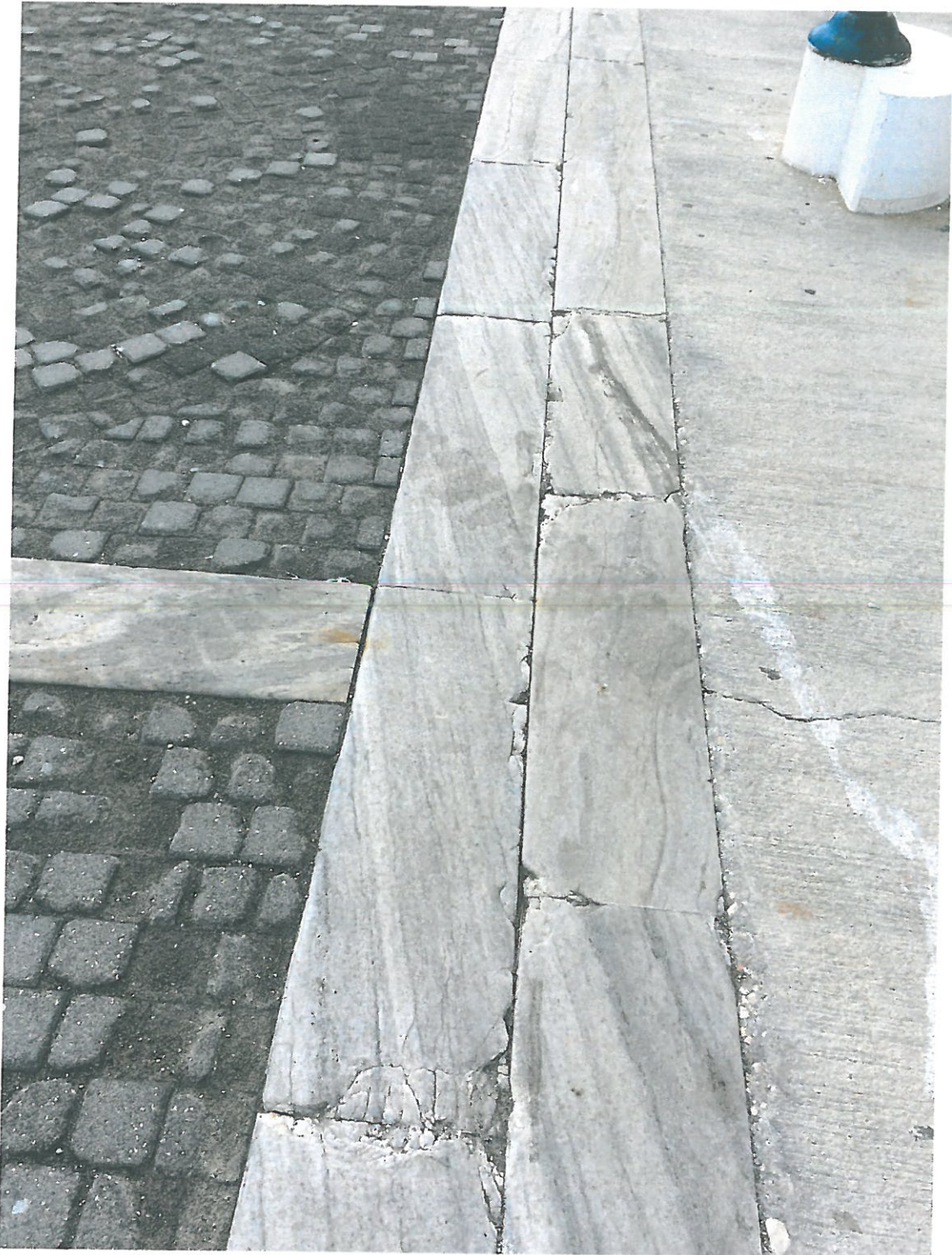
Φωτ.3: Υφιστάμενη κατάσταση υπό μελέτη περιοχής – Επίστρωση με πλάκες μαρμάρου
