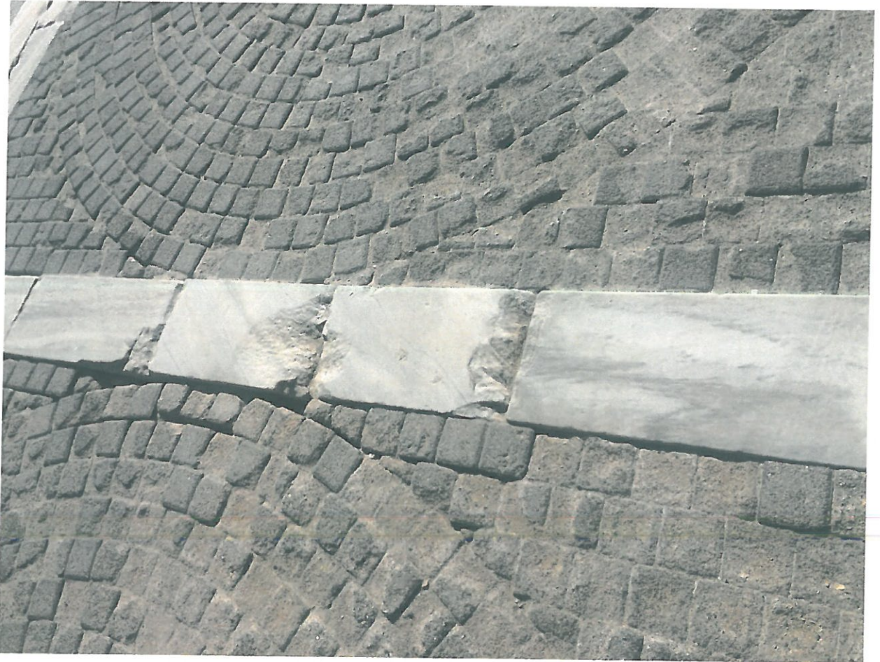
Φωτ.4: Υφιστάμενη κατάσταση υπό μελέτη περιοχής – Επίστρωση με πλάκες μαρμάρου
