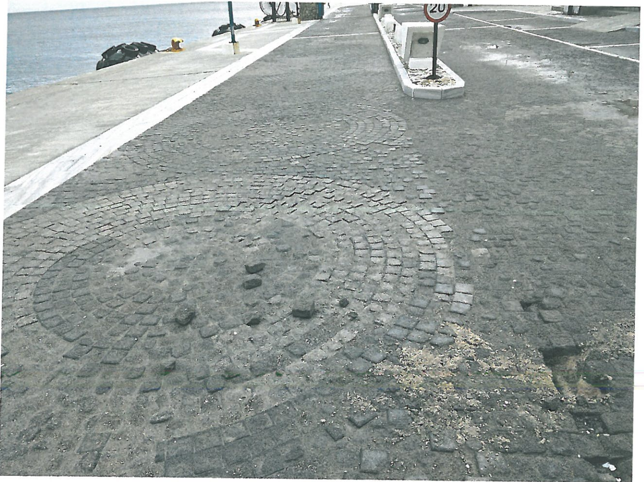
Φωτ.2: Υφιστάμενη κατάσταση υπό μελέτη περιοχής
