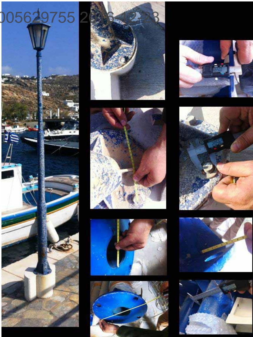
Φώτο 1: Το φωτιστικό όπως είναι τοποθετημένο στον λιμένα της Μυκόνου
