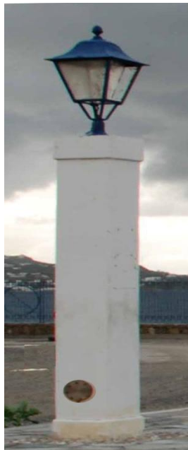
Φωτό 2: Το φωτιστικό όπως είναι τοποθετημένο στην σκυροδετημένη κολώνα, η κολώνα δεν περιλαμβάνεται στην προμήθεια
